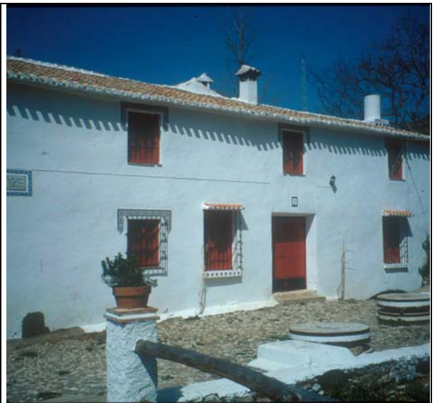
MOLINO DE LA TABLA De tradición medieval, el molino cuenta con salto de agua y acueducto. Protección B. Se proponen obras de conservación, restauración y ampliación.
